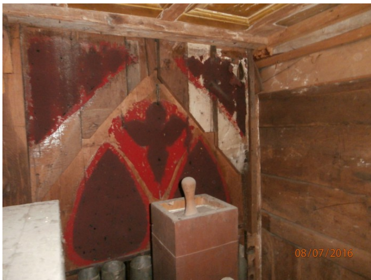
L'intérieur du buffet porte les traces des garnitures d'origine en tissu rouge
