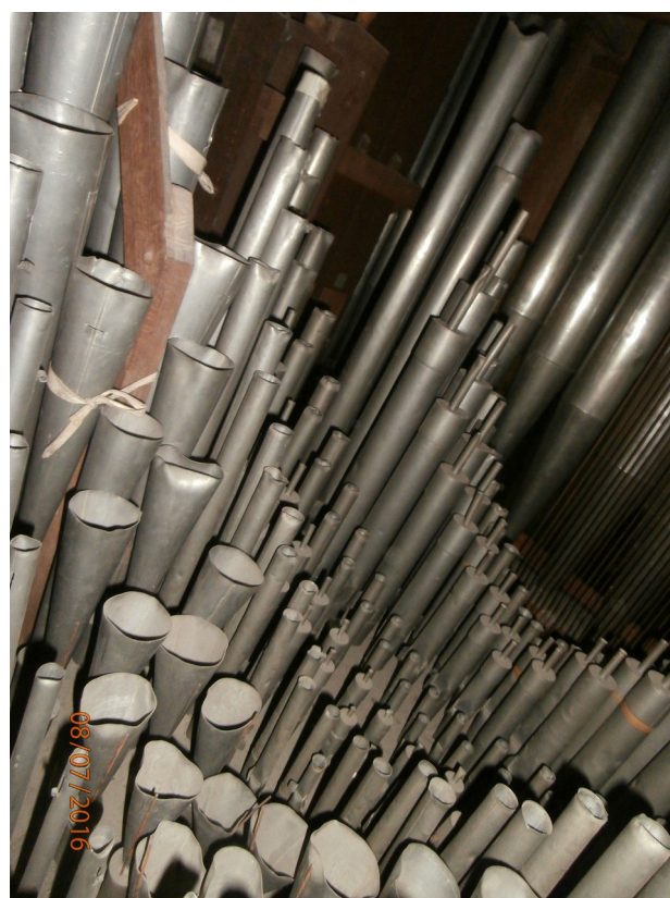
La tuyauterie du G.O. avec un salicional de Bossier à la place du Clairon, lors du démontage
