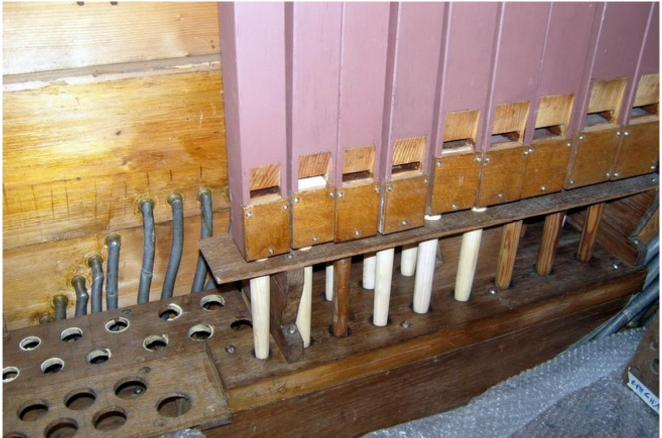
Les tuyaux de bois placés sur les sommiers; Les pieds de plusieurs tuyaux ainsi que quelques biseaux ont du être remplacés car ils étaient trop piqués par les attaques d'insectes xylophages.
