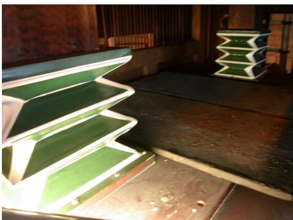
Les deux réservoirs reliés sont surpeaussés en place sans démontage sauf les couvercles d'accès supérieurs dont les joints en peau sont vérifiés pour être doublés ou remplacés pour finaliser l'étanchéité des soufflets.
