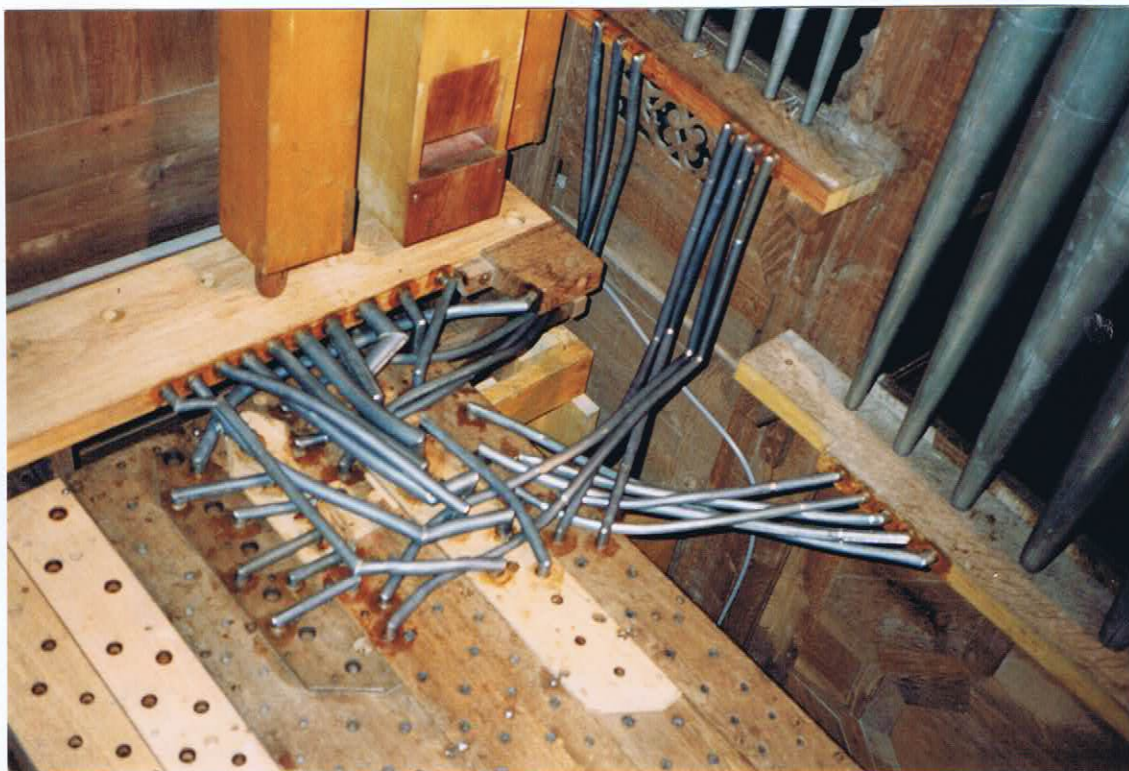
(13) Postages côté C après restauration (en plomb)
