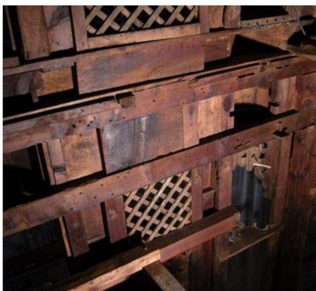
Les renforts nécessaires de la grande traverses ont été réalisés sur place et ne gênent pas le montage postérieur de la partie instrumentale.
