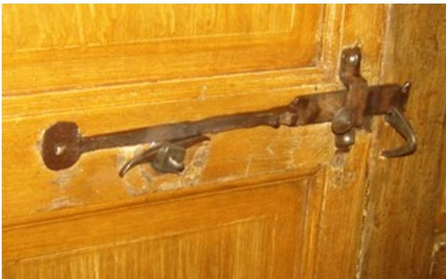
Le support de la chamade est exactement sur le même emplacement qu'à l'origine.
