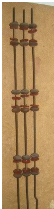
Tiges filetées de la console qui ont pu conserver leurs écrous d'origine
