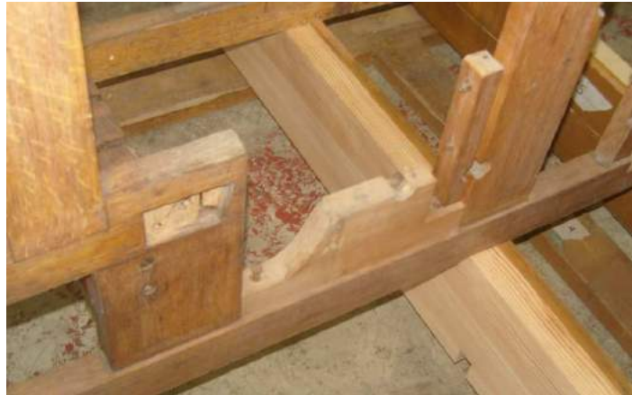
Les planchers anciens ont été réutilisés sans modification des découpes; ce qui a aidé à la reconstitution des éléments disparus
