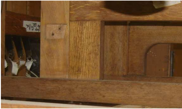
Les emplacements des barres d'équerres et la forme de leurs découpes ont permis la reconstitution de tout le tracé mécanique
