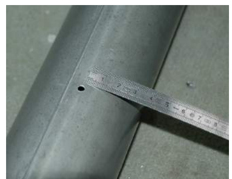
Tuyau harmonique dans la façade de Daublaine
