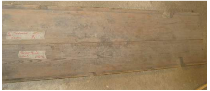
Les planchers anciens ont été réutilisés sans modification des découpes; ce qui a aidé à la reconstitution des éléments disparus
