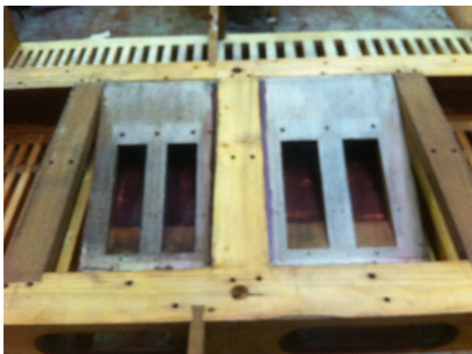
Sommier après décapage de l'intérieur et des joints d'étanchéité avec les planches de fonds de sommier.
