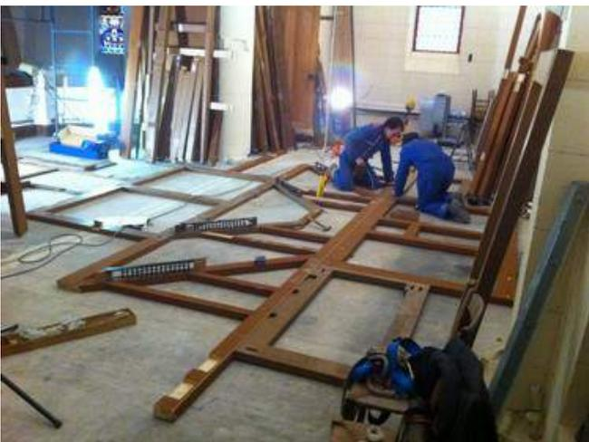
La semelle ainsi modifiée en cours de remontage et calage sur place. Il a en effet fallu revoir le calage pour compenser la planéité relative de la dalle de la tribune, légèrement affaissée en son centre. On distingue bien sur cette photo les éléments neufs des éléments anciens, légèrement plus foncés.
