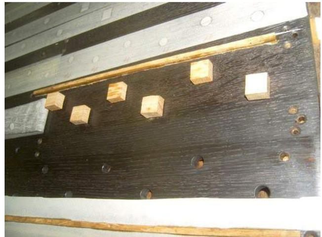
Pose des flippots : les fissures sont agrandies à la défonceuse puis les flippots sont posés et collés à la colle chaude. Pour cela, les flippots comme les entailles sont chauffées longuement pour assurer une prise la plus lente possible de la colle.
