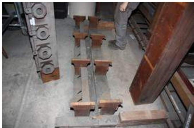
Les sommiers des extensions de pédale ont pu être séparés en 4 blocs aisément transportables, deux par jeux. Leurs supports ont été laissés assemblés pour simplifier le démontage, leur transport en fut facilité. Par contre les râteliers des 16' et 32' ont été démontés au maximum tant ils étaient imposants.
