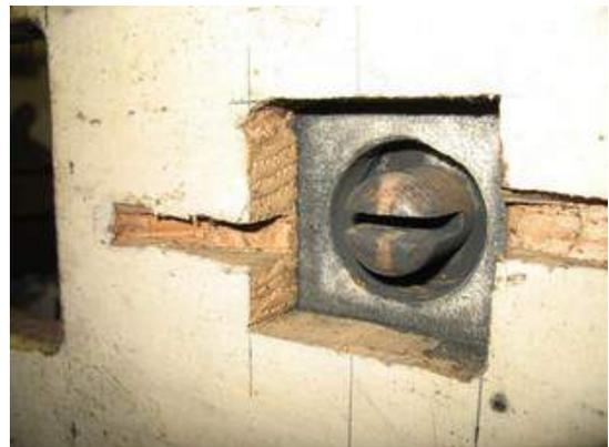
Point d'attache de la ferraille du régulateur dans la table supérieure du réservoir.
