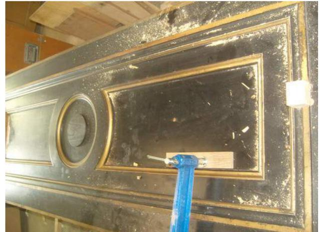
Il est apparu que plusieurs morceaux de moulures étaient manquants ou abîmés, il a donc fallu les remplacer et les compléter.
