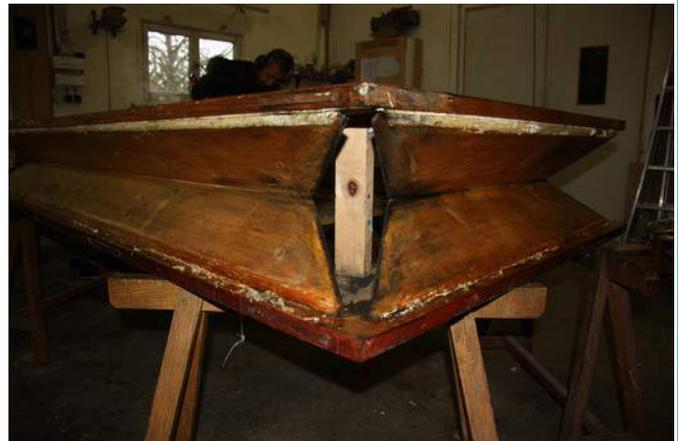
Après décapage complet des papiers extérieurs, posés sur les bandes de peau, les éclisses sont désassemblées.
