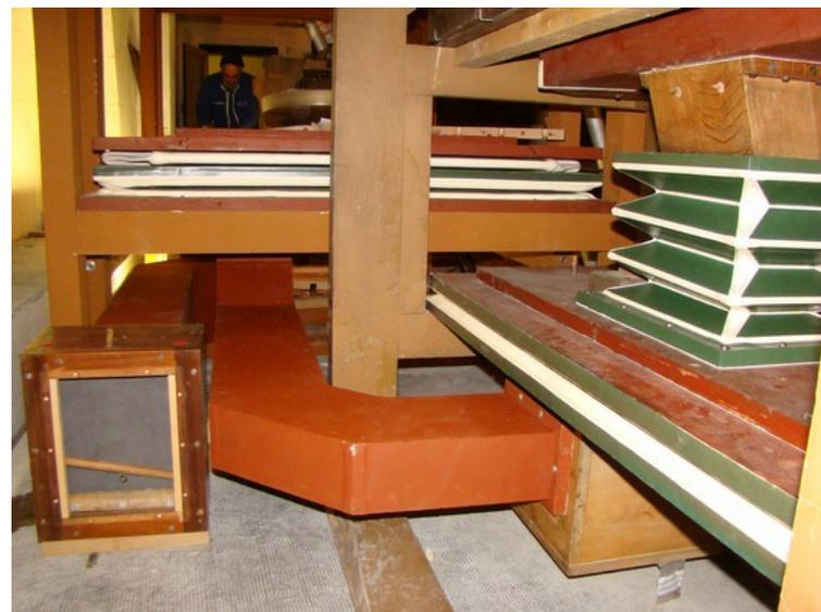
Puis les liaisons de porte-vent ont été installés, de façon à pouvoir rapidement vérifier une dernière fois l'étanchéité des diverses liaisons, tant qu'elles étaient encore accessibles (avant que les éléments de mécanique note et mécanique jeux soient installés).
