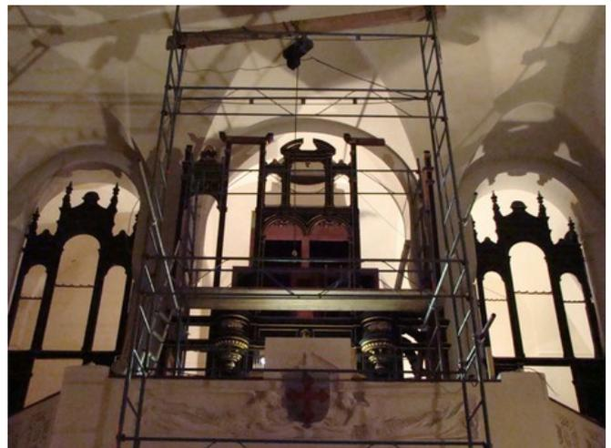
Une fois toutes les grosses pièces installées à l'intérieur de l'instrument, le buffet a été peu à peu remonté. Les assemblages étaient pour la plupart très aisés à remettre, puisqu'ils utilisent des gros boulons comme ceux utilisés traditionnellement pour l'assemblage des armoires.
