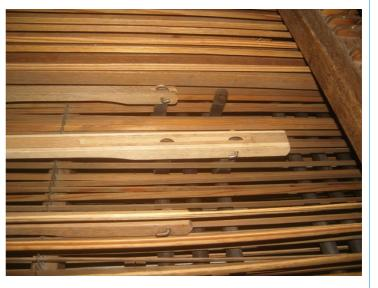
Trains de vergettes superposés sous le plancher reliant la console au buffet. On distingue au centre les modifications, complètement réversibles, apportées aux rouleaux et aux tirants des commandes de boîtes expressives. En effet, la bascule de droite, commandant au départ le Récit, commande désormais l'Eoline, placée avant au centre. Ainsi, les boîtes du Positif et du Récit, peuvent être maniées en même temps pour un effet cumulé.
