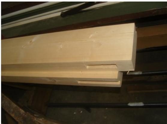
Les éléments de charpente neufs ont été fabriqués en copie de facture des anciens. Cela a nécessité de copier les assemblages complexes typiques de charpentes Cavallé-Coll, comme on peut le voir sur les photos ci-contre et ci-dessous. Ci-dessous à droite, comparaison avec un assemblage ancien (charpente GO/POS).
