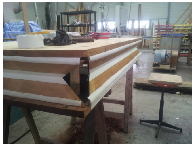
Assemblage des éclisses sur les tables inférieure et supérieure d'un réservoir du Récit
