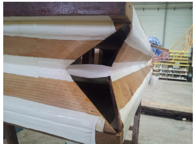
Pose des éclisses et des bandes de peau les reliant au niveau des aines (voir p. précédente)
