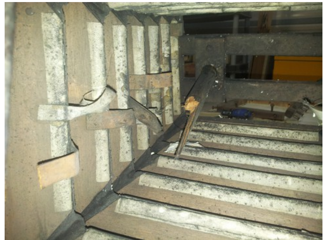
Intérieur d'un gosier avant remise en peau complète (cf. p. suivant pour voir la même vue après travaux)
