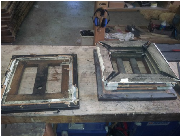
Gosier en cours de démontage
