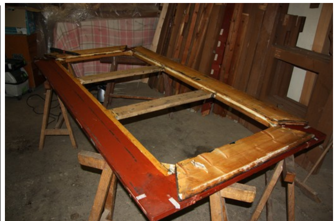
Les positions d'implantation des éclisses et notamment d'arrêt des bandes de peaux les reliant à la table sont marquées par des scotch.
