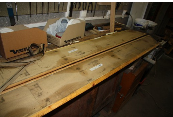
Les papiers intérieurs sont en bon état, même sur le primaire, il est donc inutile et destructeur de les changer. Ils sont donc laissés en place.
