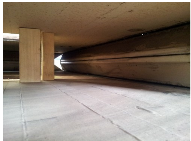
Même réservoir après nettoyage intérieur et décapage des éclisses.
