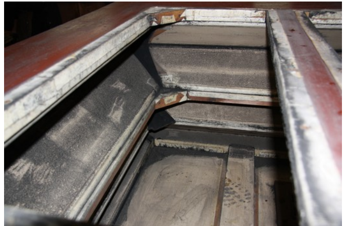
Encrassement important du réservoir primaire, ce qui est logique puisque c'est celui qui reçoit en premier l'air du moteur (air extérieur).
