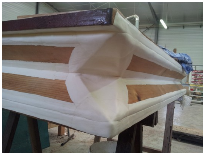
Fin de la pose des bandes peau et des nouvelles aines sur un réservoir de Récit
